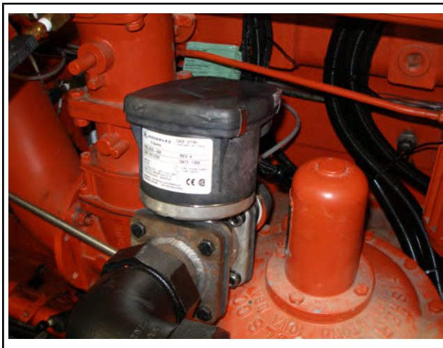
Рисунок 2.00-24: Регулятор подачи топлива
