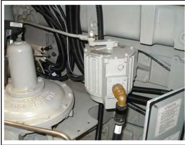
Рисунок 2.00-23: Электрический силовой привод и узел дроссельной заслонки
