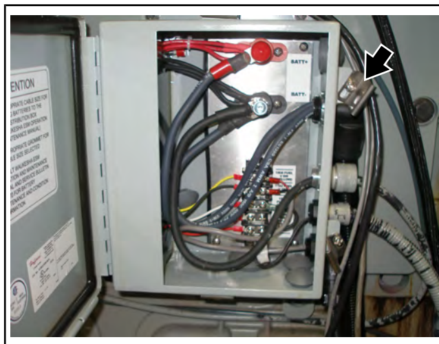
Рисунок 2.60-8: Фиксатор и винт крышки распределительной коробки
