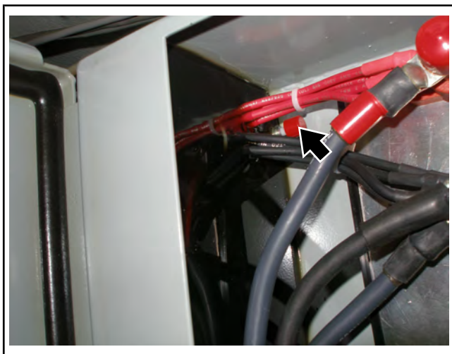
Рисунок 14.05-1: Переключатель сброса
