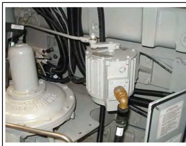
Рисунок 2.05-1: Электрический силовой привод и узел дроссельной заслонки
