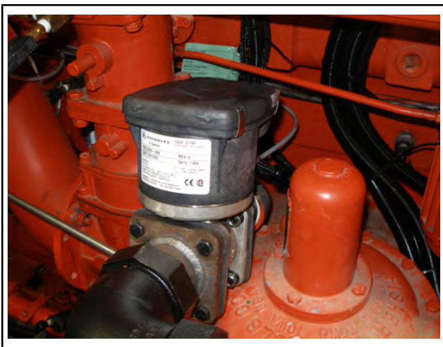
Рисунок 3.05-6: Регулятор подачи топлива
